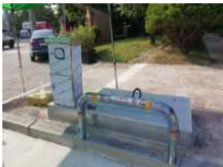
<충전기 설치전 전경(실외)>
