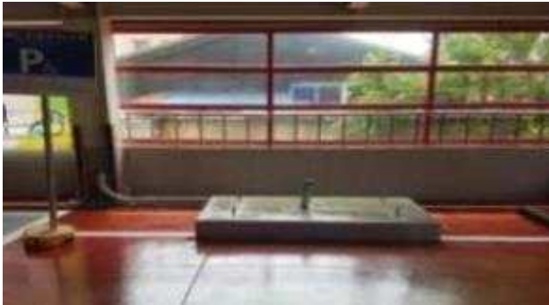
<기초 공사 (실내) 예시>
