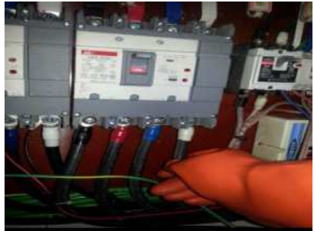
케이블 조임 상태 확인 예시
